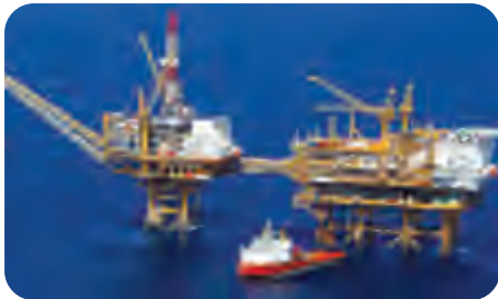
海洋平台管桩 Offshore platform pile
