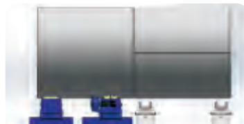
C、第一段组对完成 C、 No.1 & No.2 pipe fit up together
