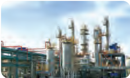
石油化工塔器 Petroleum chemical tower
